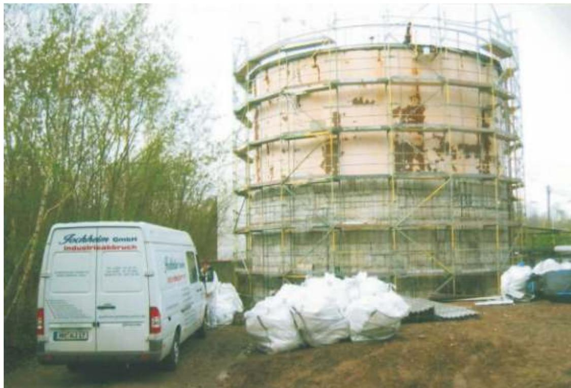
Rückbau der Aluminiumverkleidung. Entnahme der Glaswolle-Isolation und verpacken in Bitbags.
